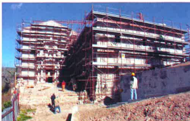
il complesso polifunzionale della Badia Grande a S. Marco d'Alunzio durante le attività di recupero
