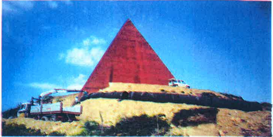
una delle fasi di costruzione della cultura Piramide - 38° parallelo: installazione del tunnel ipogeo.
